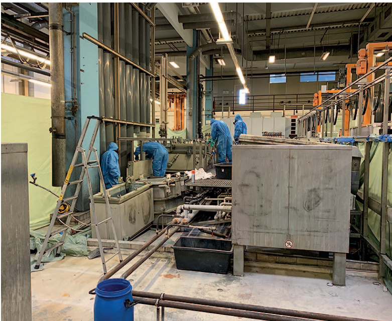
762 Rückbau einer Galvanik
